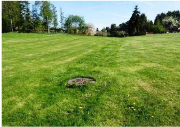
Figur 5. Exempel på översilningsyta/torrdann. En översilningsyta är en lätt sluttande gräsyta dit vatten från vägar och andra hårda ytor leds. Vattnet renas när det sprids över gräsytan och filtrerar ner i jorden. För att skapa fördröjning regleras bräddnivån med exempelvis en brunn.
