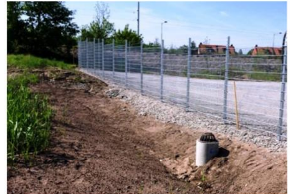
Figur 6. Exempel på svackdike. Svackdiken kan vara gräsbeklädda men kan även bestå av grusfyllning. Dikena fungerar både som infiltrationsyta och öppet avrinningsstråk och har beroende på utformning, mer eller mindre förmåga att fördröja dagvattnet.
