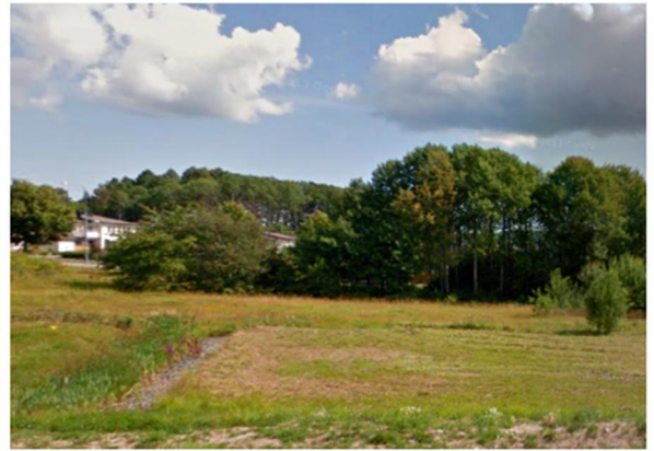
Figur 5. Exempel på översilningsyta/torrdann. En översilningsyta är en lätt sluttande gräsyta dit vatten från vägar och andra hårda ytor leds. Vattnet renas när det sprids över gräsytan och filtrerar ner i jorden. För att skapa fördröjning regleras bräddnivån med exempelvis en brunn.
