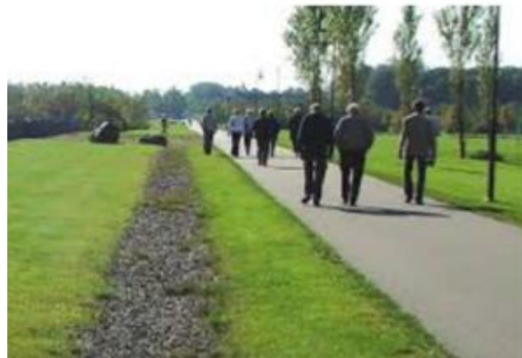
Figur 6. Exempel på svackdike. Svackdiken kan vara gräsbeklädda men kan även bestå av grusfyllning. Dikena fungerar både som infiltrationsyta och öppet avrinningsstråk och har beroende på utformning, mer eller mindre förmåga att fördröja dagvattnet.
