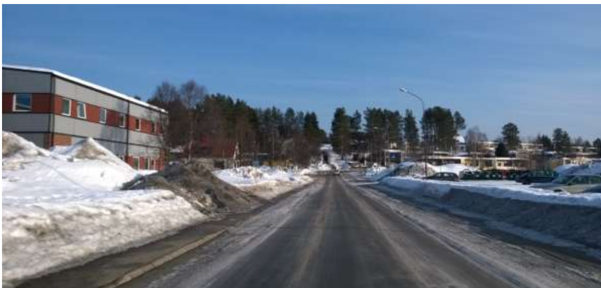
Figur 14. Hellebergsvägens befintliga utformning med kantstensbunden gc-väg på ömse sidor. Utsikt i nordlig riktning upp mot bostadsområdena vid Vallmovägen.
