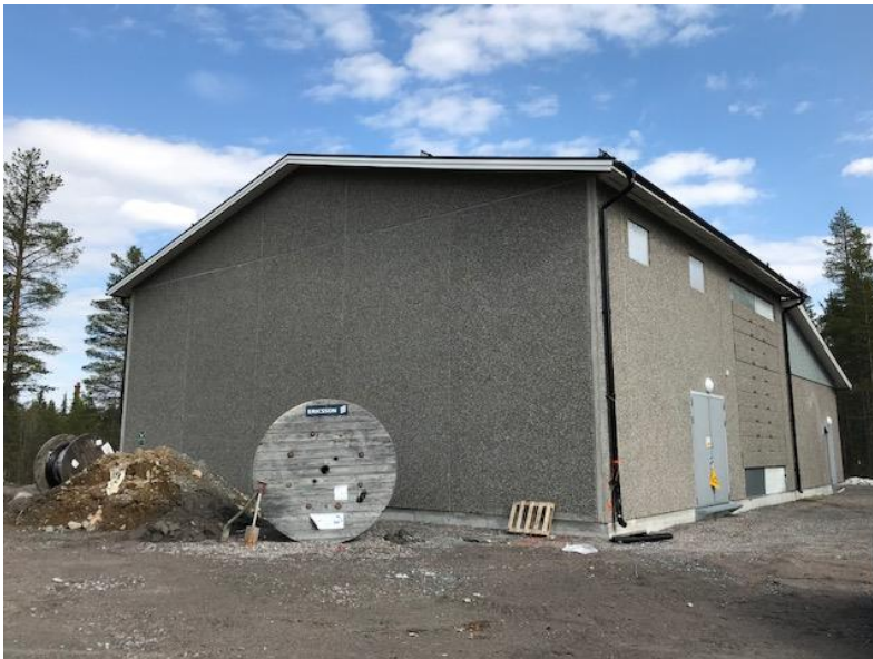
Figur 5. Foto tagen från befintlig infart och visar transformatorstationens västra och södra fasad.
