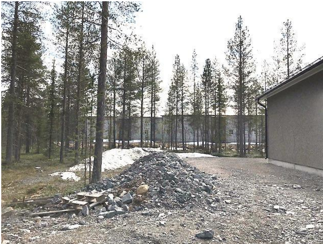
Figur 4. Foto tagen från planområdet mot befintligt flerbostadshus med transformatorstationen i förgrunden.
