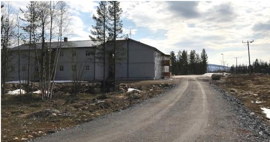
Figur 6. Foto tagen från transformatorstationen och visar intilliggande bostadshus samt kraftledningen som passerar planområdet.
